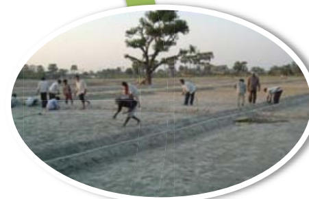
3. खेत की तैयारी एवं नाला निर्माण
